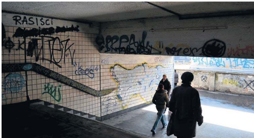
► Przejście podziemne - tunel zachodni - wygląda brzydko. Ale podobno jest codziennie sprzątane
